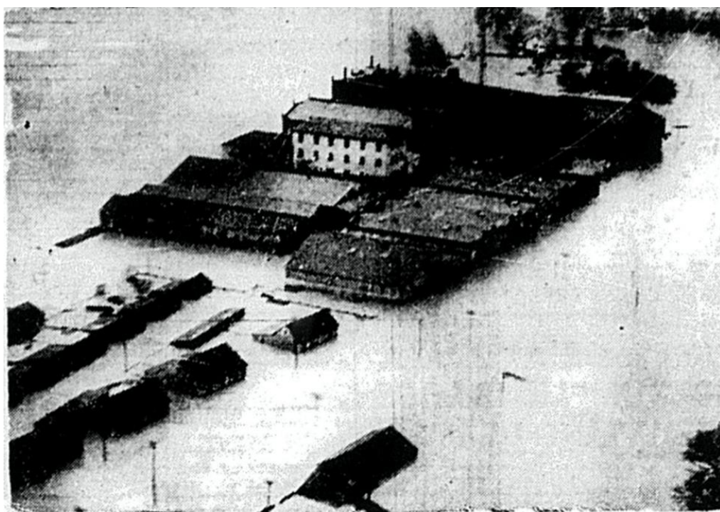
MOLINO KUNSTMANN INUNDADO. — FOTOGRAFIA TOMADA bajo torrencial lluvia, desde un helicóptero, el miércoles último y que capta las instalaciones completas del Molino Kunstmann, en el barrio Collico, invadidas por el agua. Ayer había bajado bastante el nivel del agua y esa
